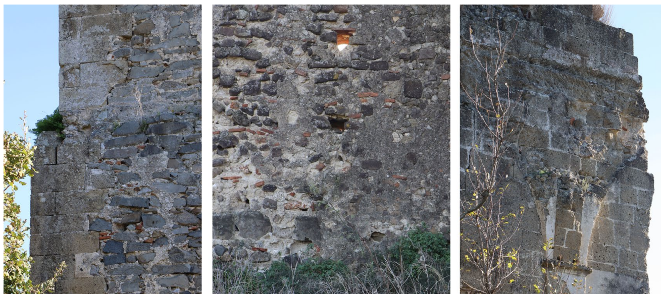
Fig. 11. Dall'osservazione diretta della fabbrica si individuano: la struttura del campanile (a); la consistenza del paramento delle murature perimetrali della chiesa (b) e dell'attuale facciata principale dei resti della chiesa di Santa Maria della Piana (c) (foto Luigi Cappelli 2023).
