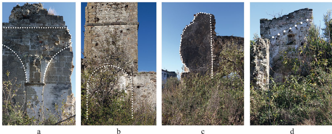
Fig. 5. Dall'indagine visiva della preesistenza si distinguono: tracce di un portico (a); segni di un probabile nartece (b e c) e la presenza di una copertura a falde per la navata centrale (d).
